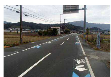
亀岡園部線 車道混在型（矢羽根） (南丹市八木町)
