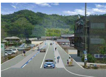
整備イメージ 園部停車場線 普通自転車専用通行帯 (南丹市園部町)
