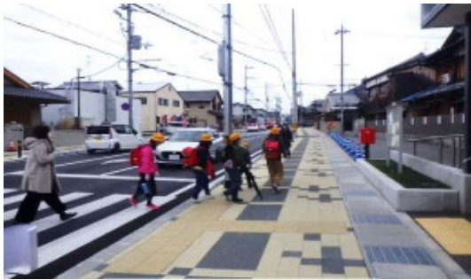
西京高槻線（向日市）
