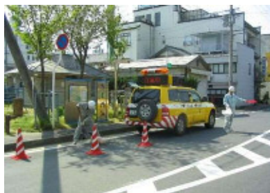
道路パトロール 舗装ポットホール修繕状況
