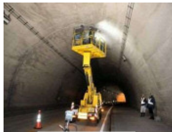
トンネル点検
