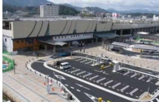
福知山駅付近連続立体交差事業
