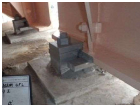
計画的な補修による延命化
