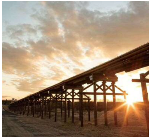
上津屋橋（流れ橋）（八幡市～久御山町）
