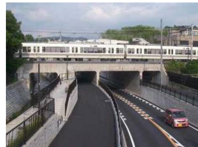
鉄道との立体交差を含むバイパス整備 宇治淀線(宇治市)
