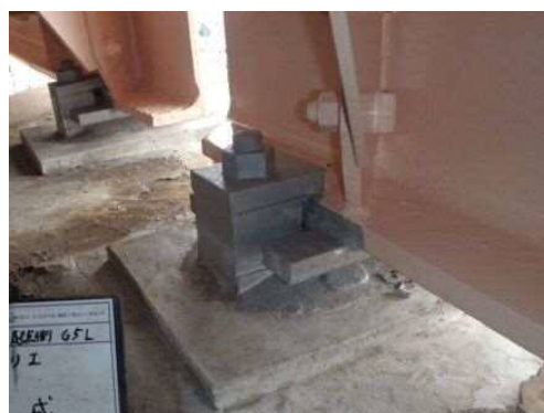
計画的な補修による延命化
