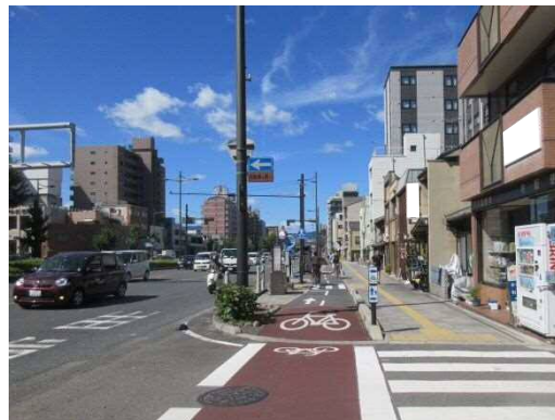
国道1号・五条通（京都市）
