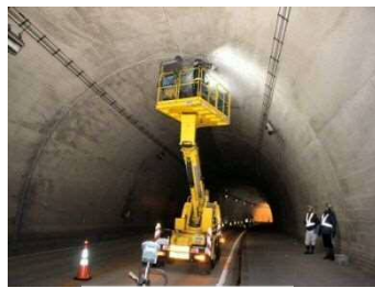
トンネル点検
