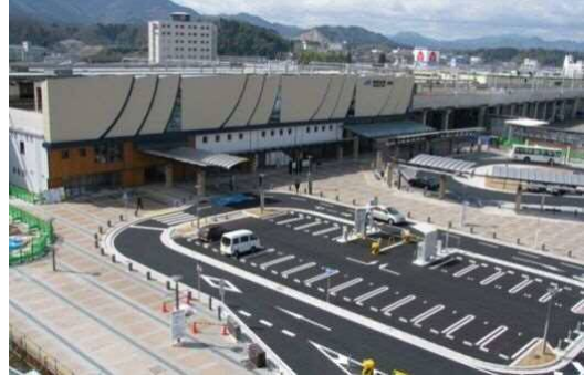
福知山駅付近連続立体交差事業
