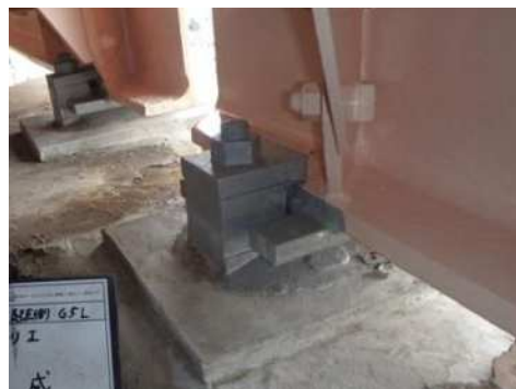
計画的な補修による延命化
