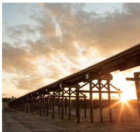
上津屋橋（流れ橋）（八幡市～久御山町）
