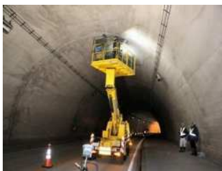
トンネル点検
