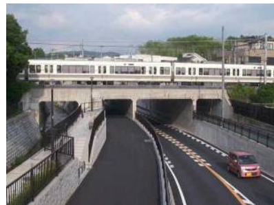
鉄道との立体交差を含むバイパス整備 宇治淀線(宇治市)
