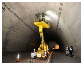
トンネル点検
