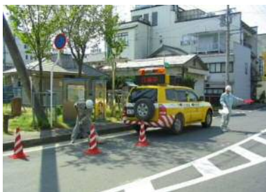
道路パトロール 舗装ポットホール修繕状況
