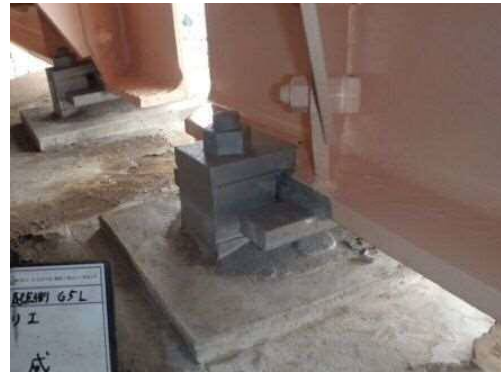
計画的な補修による延命化
