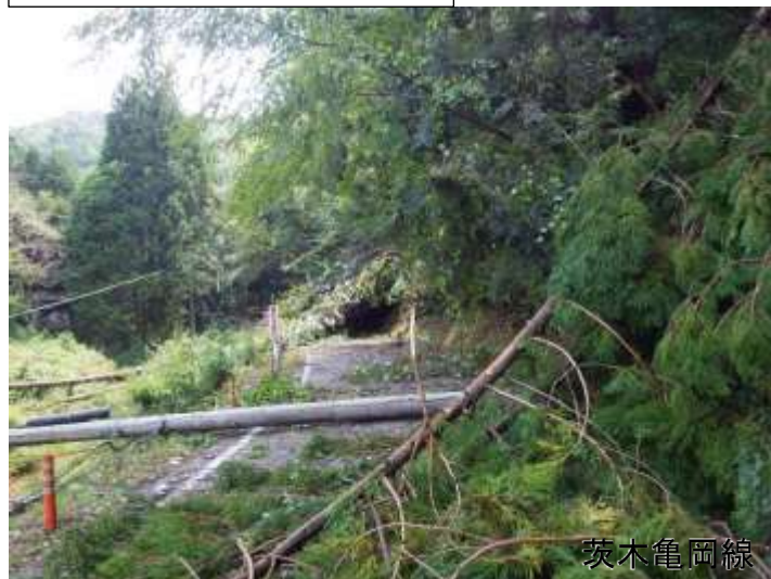
電柱倒壊、倒木 (H30. 9)
