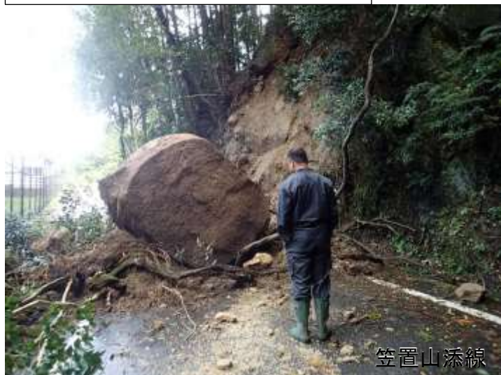
道路区域外からの落石 (H29. 10)
