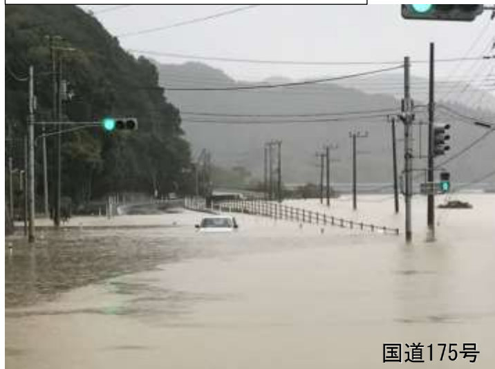
由良川氾濫による冠水 (H29. 10)
