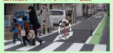
通行規制+ライジングボード設置
