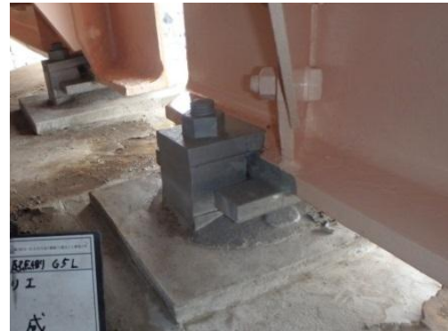
計画的な補修による延命化
