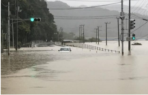
平成 30 年 7 月豪雨による 由良川沿川道路の冠水（福知山市）
