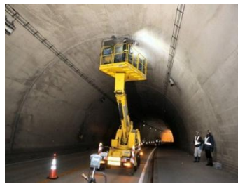
トンネル点検
