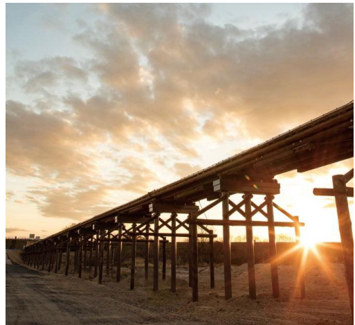
上津屋橋（流れ橋）（八幡市～久御山町）
