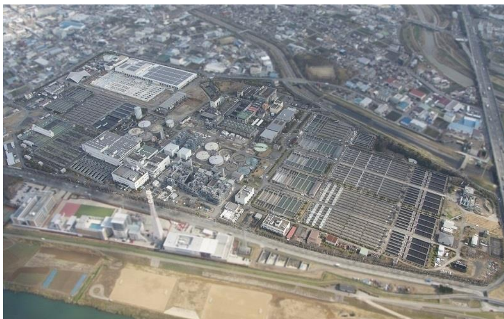
鳥羽水環境保全センター
