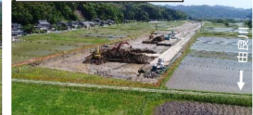
地盤改良・樋門の新設を実施
