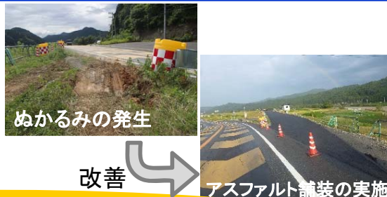
アスファルト舗装の実施
