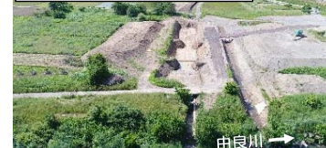
地盤改良・樋門の新設を実施
