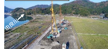
地盤改良・樋門の新設を実施
