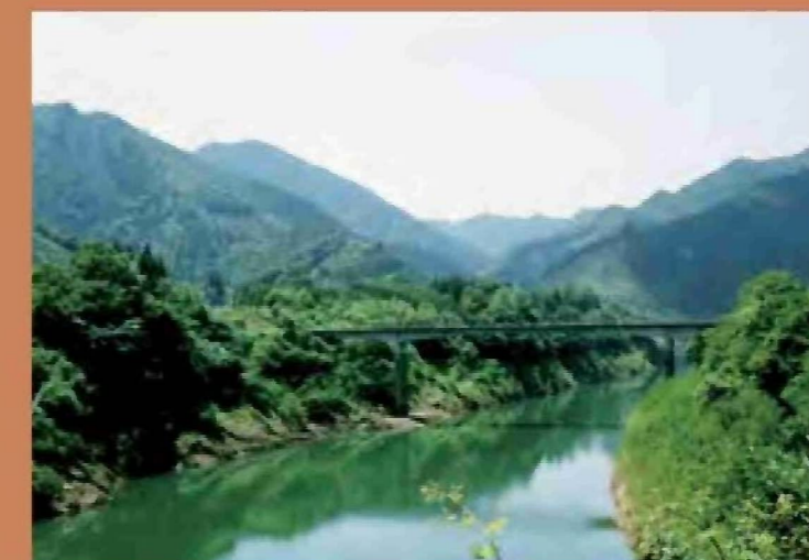
同時期に架けられた脇谷橋 橋長110.0m、幅員5.5m
