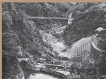
仮排水路へ転流完了 昭和33年5月末
