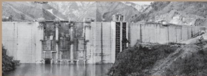
ダム打設天端工事進行中 昭和36年1月末
