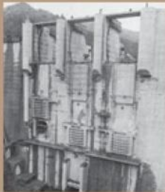
コースターゲートも組立られ、コンジット内部でも圧縮高圧ゲートの組立が行われている 昭和35年11月末
