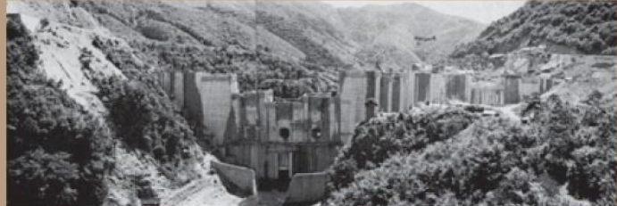
コンジット前面の非常用コースターゲート組立始まる ダム本体コンクリート150,000m 3 昭和35年7月末
