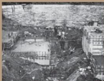
ダム本体Aブロック先行型で、昭和33年12月6日 ダム本体コンクリート打設始まる 昭和34年1月末
