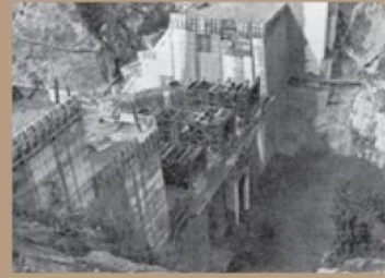
主放水管コンジット掘削中 昭和35年2月末
