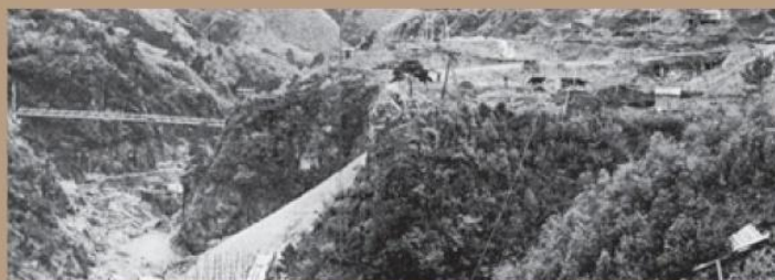
仮設備工事に着手したダムサイト 昭和33年5月末
