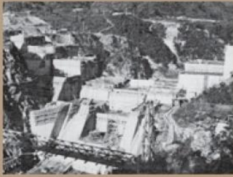
順調に打上げるダム本体、主放水管コンジットの下流端トランプ部分の掘削が始まる 昭和34年11月末
