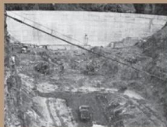
ダムサイトを下流から見る。すでに上流2次締切も完成、河床部の基礎掘削、コンソリデーショングラウトも実施中 昭和33年10月末
