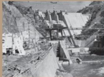
ダムサイト下流から見る右岸発電所クレーン・放水口も姿を現した 昭和36年1月末
