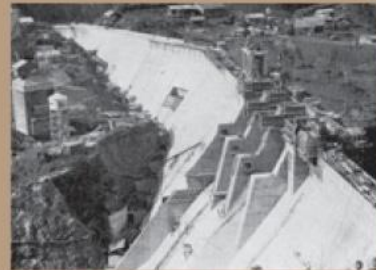
ピアー頂部工事状況 昭和36年1月末
