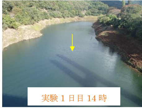
貯水池 (向山橋付近) (堤体上流 2km 付近)
