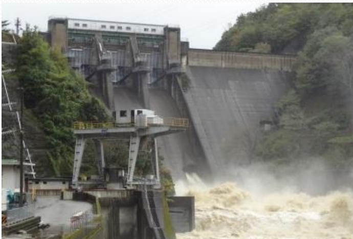
大野ダムの放流状況
