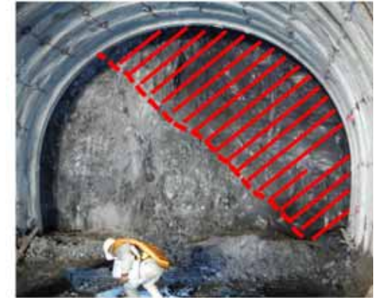
赤斜線部は脆弱層(破砕帯)を示す
