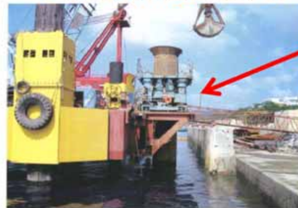
〔 施工例(水上施工) 〕
