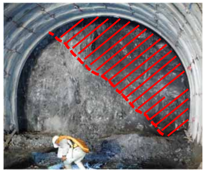
赤斜線部は脆弱層(破砕帯)を示す
