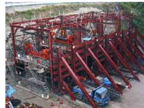
パイプルーフ推進架台全景(事例)
