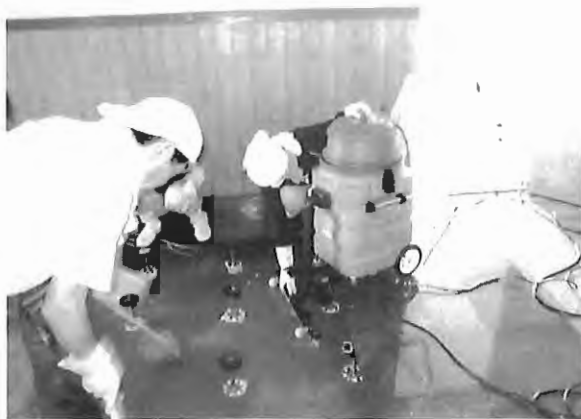
床下に溜まった水の排出
