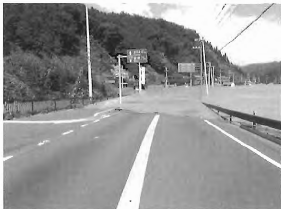
平成25年9月16日 大川橋（舞鶴市）付近
