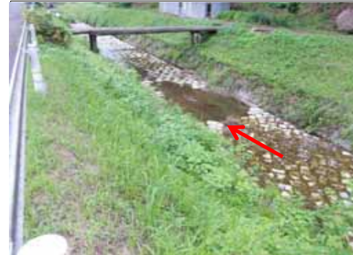
祖母谷川(多門院) 河床張コンクリートの破損
