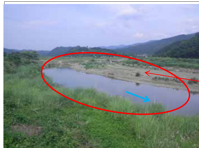
浚渫工、 河床整正
