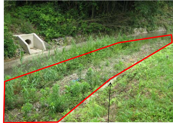
既設ブロック天端
