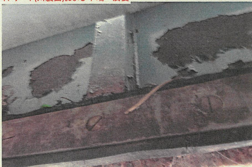
スライドゲート(川裏面)および下端－腐食
