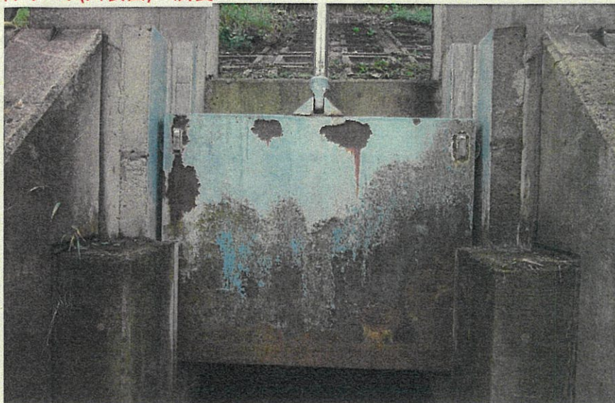
スライドゲート(川裏面)および下端－腐食
