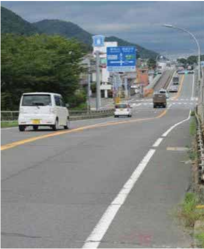
丹波大橋上から西方向の状況
