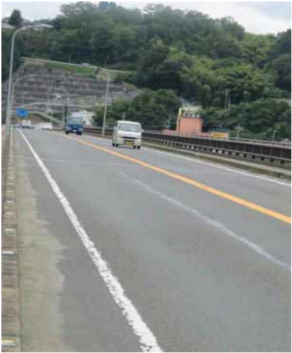
丹波大橋上から東方向の状況
