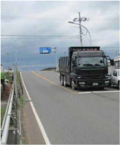
丹波大橋東詰から西方向の状況
