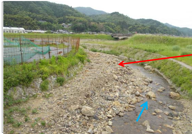
浅原川 浚渫工
