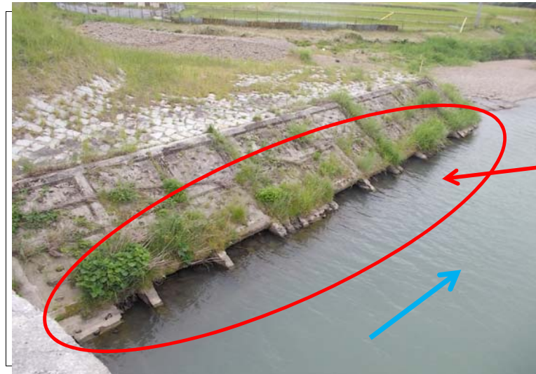
上林川 護岸工・根固工
