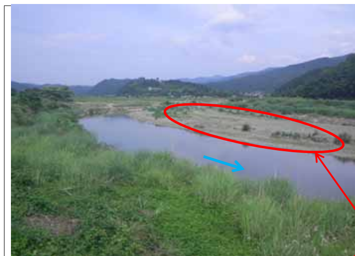
浚渫、 河床整正
