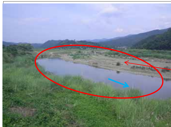
浚渫工、 河床整正
