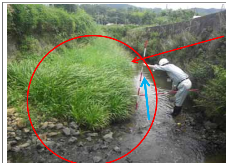
浚渫工・河床整正
