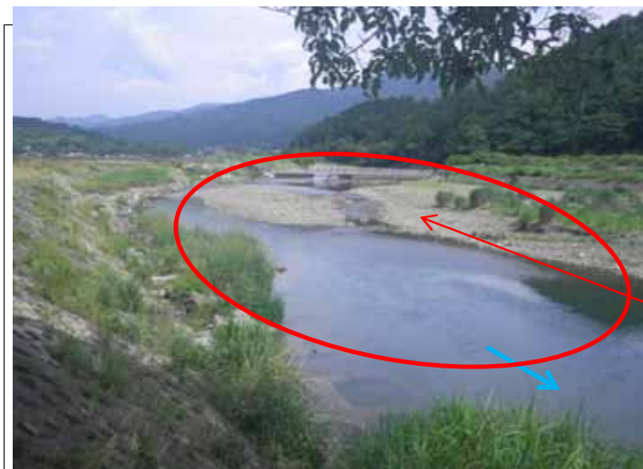
浚渫工、 河床整正
