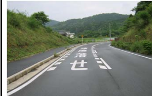
路面標示実施済み (四所から岡田由里)
