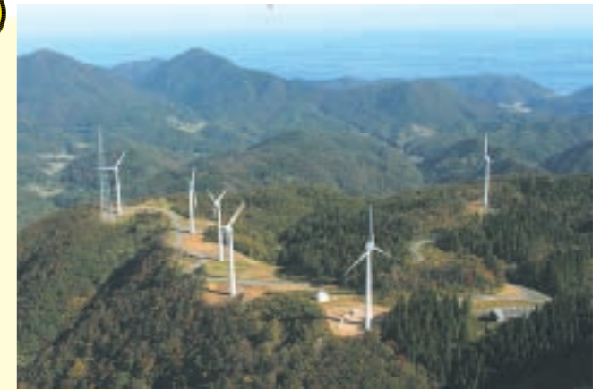
太鼓山風力発電所
