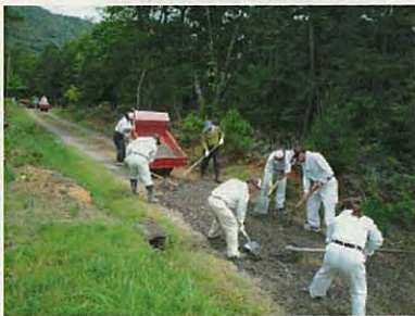
碎石敷き均し100m
