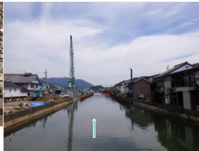
高野川河川改修（舞鶴市竹屋～引土）
