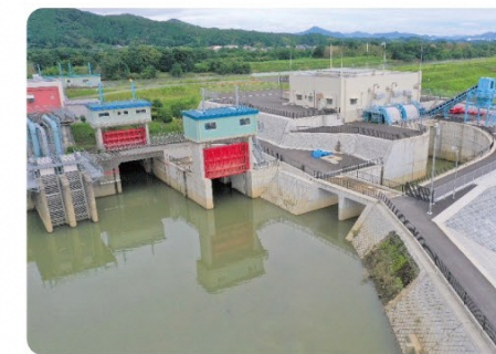
新荒河排水機場
