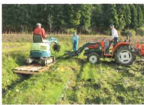
共同水路の整備作業
