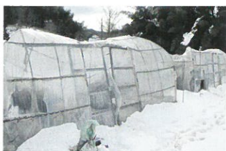
雪害で倒壊したビニルハウス
