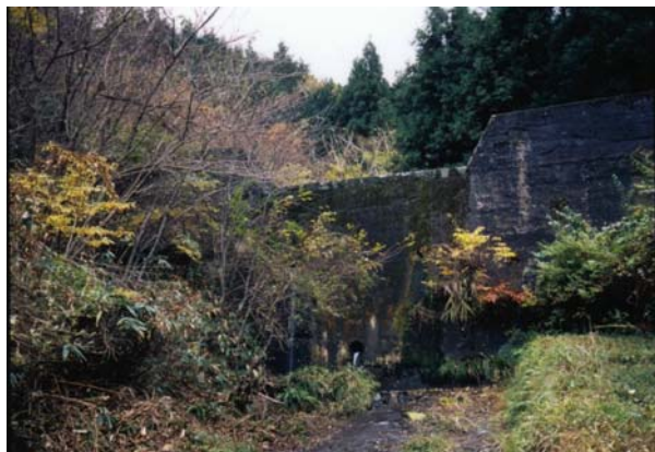
周辺の景観にとけ込むえん堤（現在）
