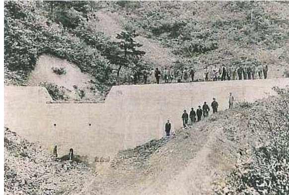
上三岳川第1号堰堤完成時の状況（昭和15年撮影）
