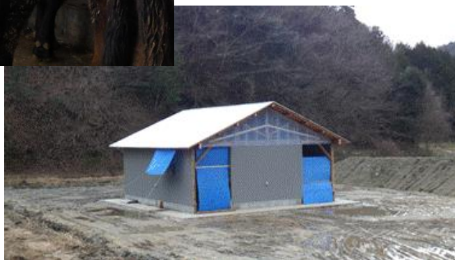
自力施工による完成間近の牛舎
