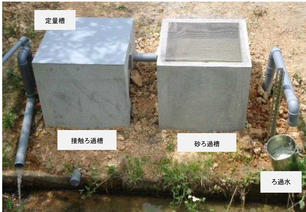
図3 当センターで試作・設置した小規模な実証プラント
