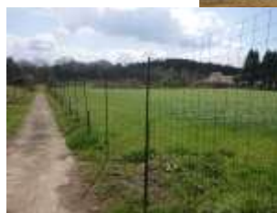
野生鳥獣侵入防止柵を設置
