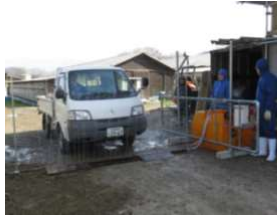
養豚場への設置後の動作確認
