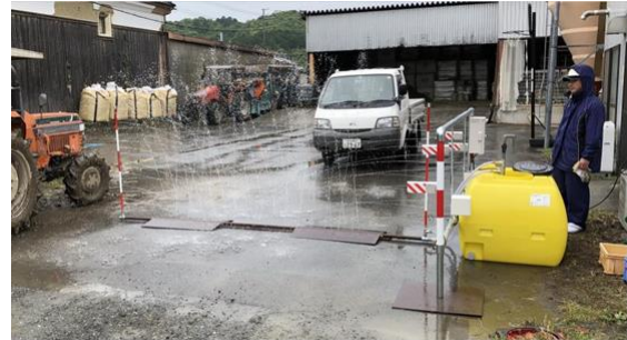
設置した消毒装置での試運転の様子
