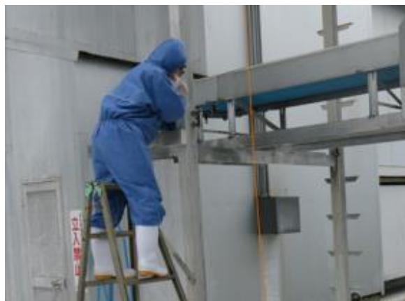
開口部周囲へのセンサカメラ設置作業
