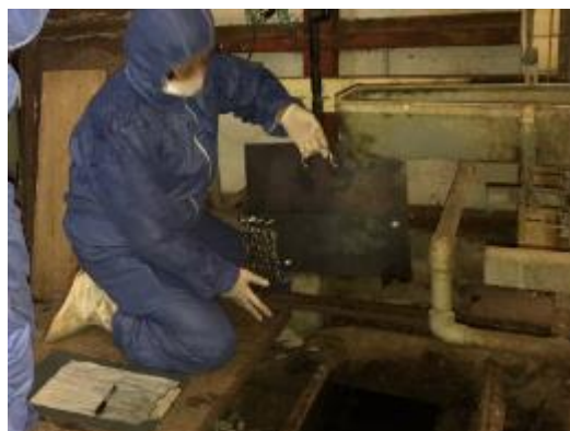
構造が複雑で密閉が困難なバークリーナ終末部には鉄板とチェーンを組み合わせた蓋を考案し設置
