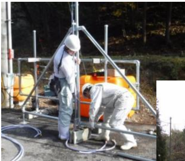
当センターによる設置工事の様子
