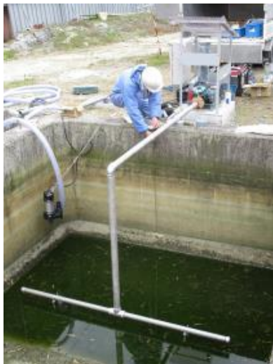
当センター職員による設置工事
