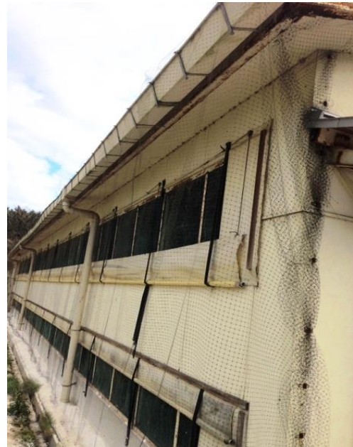
鶏舎開口部の網と鶏舎全体を覆おう ネットの併用で厳重に防鳥対策
