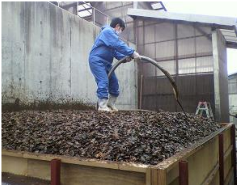
完成した脱臭施設へ種菌を投入
