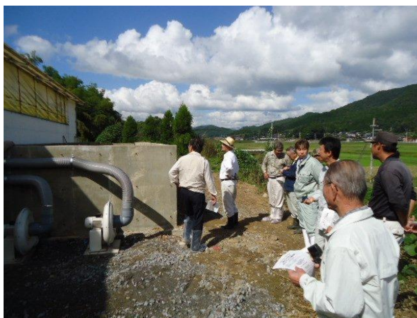
稼働開始時に地域住民へ現地説明会を開催（10月9日）
