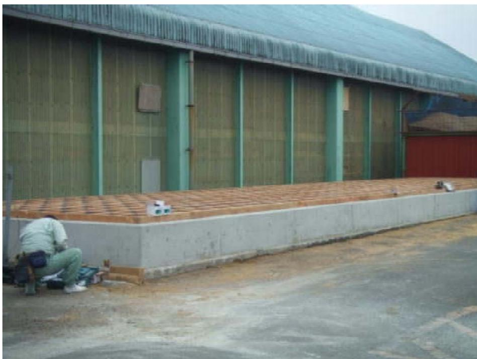
堆肥化施設の横に設置中の脱臭装置の脱臭槽（土台部分）
