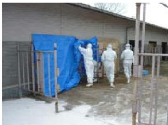
牛舎側面の開口部を防鳥獣ネット、コンパネ、ブルーシートで封鎖
