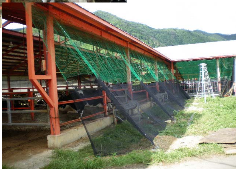
緑のガラスネットとつなげて黒いハエネットを設置
