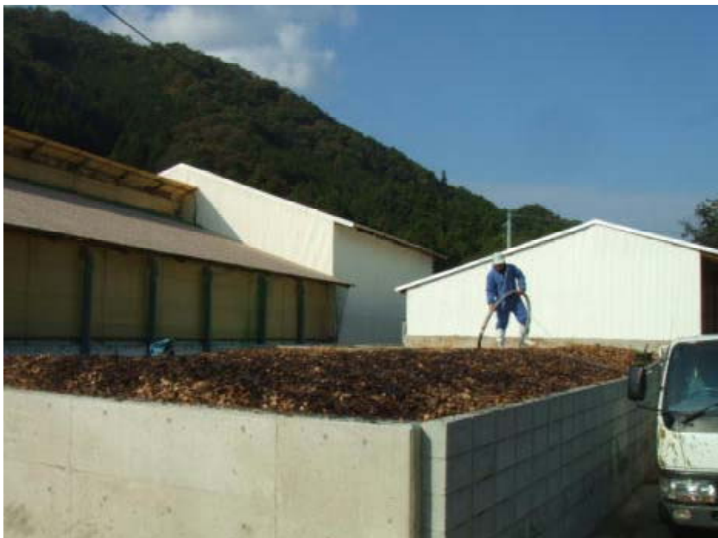
脱臭装置への硝化・脱窒細菌の植種の作業
