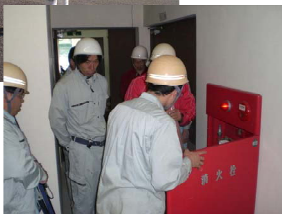
器具機材の点検・確認
