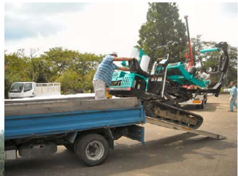
作業機械の運搬
