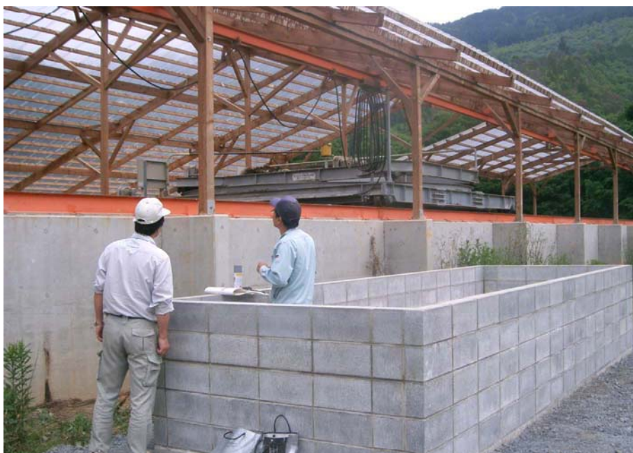
現地で脱臭装置の設置工事を指示
