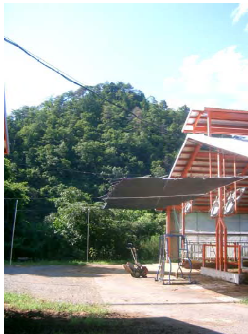
完成した遮光ネット
